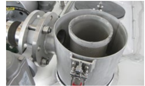
Selbstreinigender Fäkalienfilter Self cleaning waste filter
